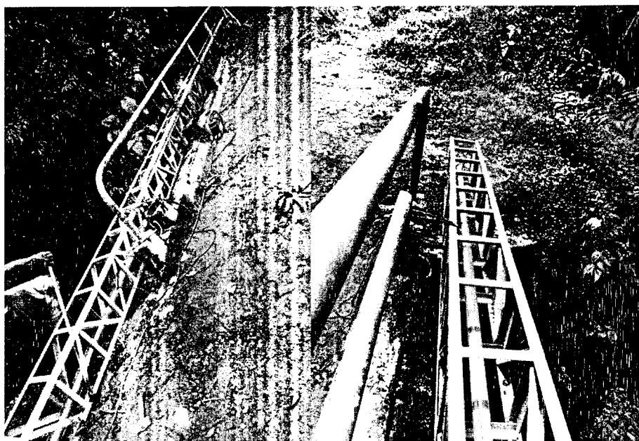
Instalación de Cercha de 12 metros - en el paso especial sobre la quebrada la soledad, vereda el corazón
